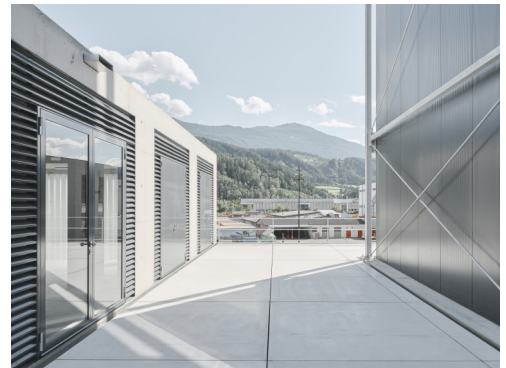
Hocheffizientes Blockheizkraftwerk im GUTMANN Pelletsspeicher
